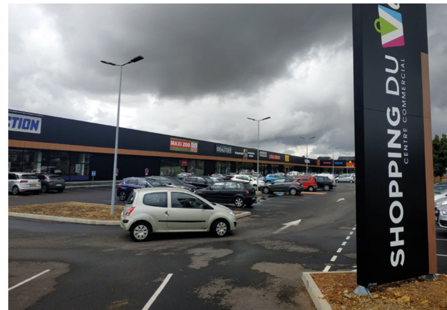
La nouvelle zone d'activités commerciales « Shopping du Val ».
